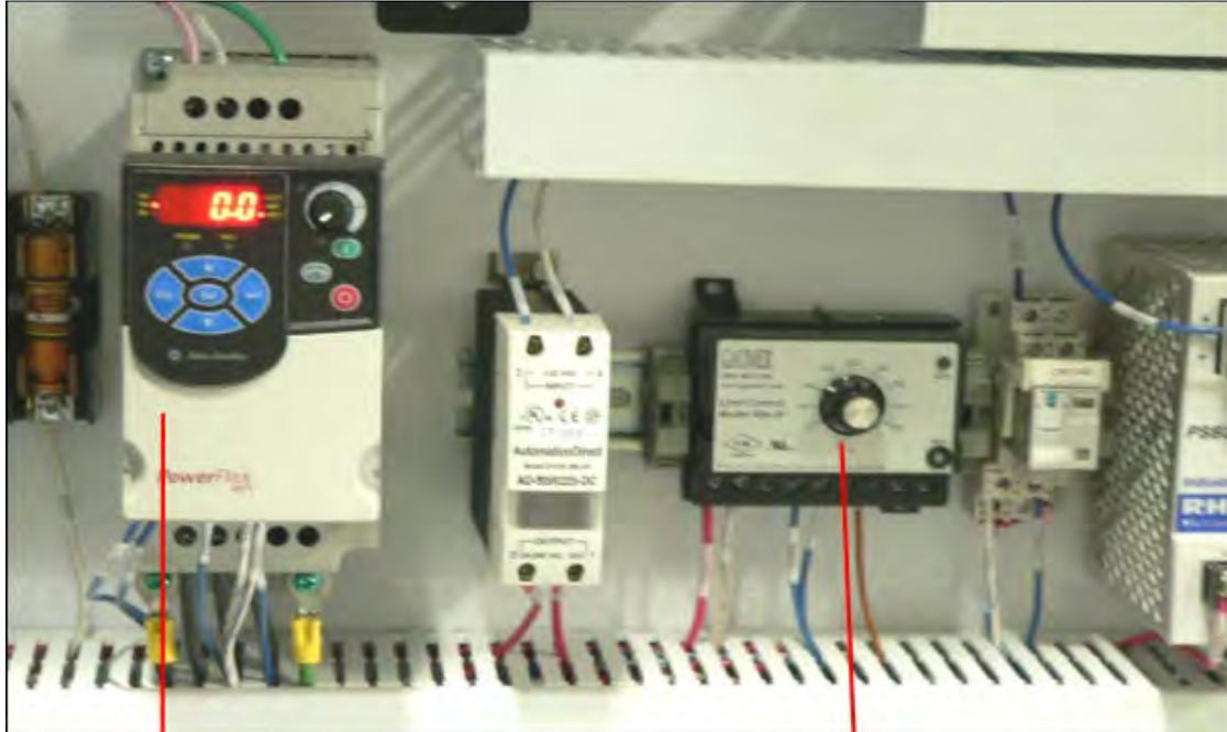
Fuel Pump Variable Frequency Drive (VFD)
